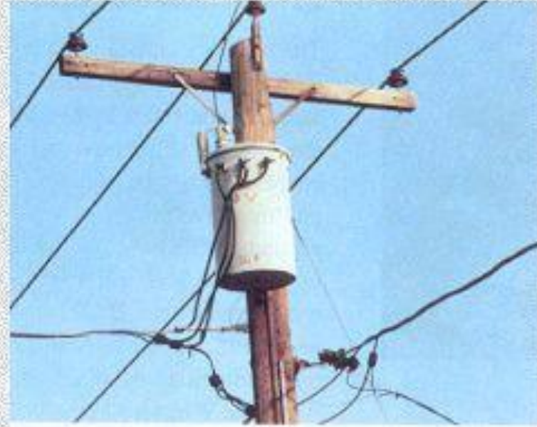
Letranszformálás 8000V-ról 230 V-ra
