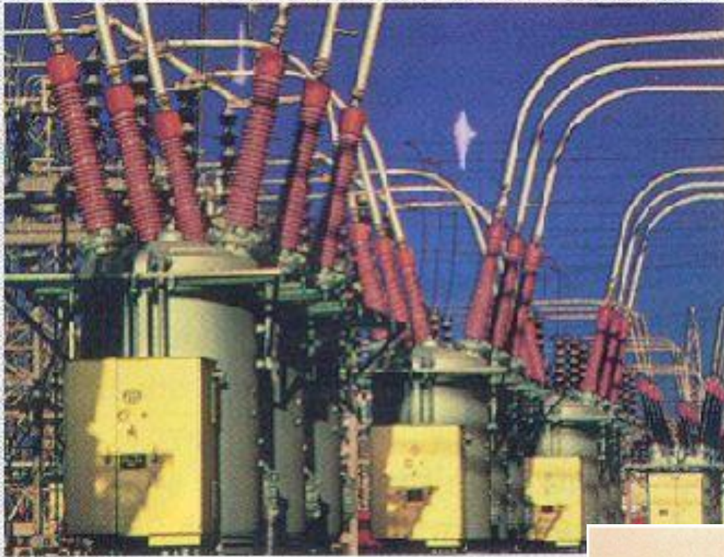
Letranszformálás 240000 V-ról 8000 V-ra
